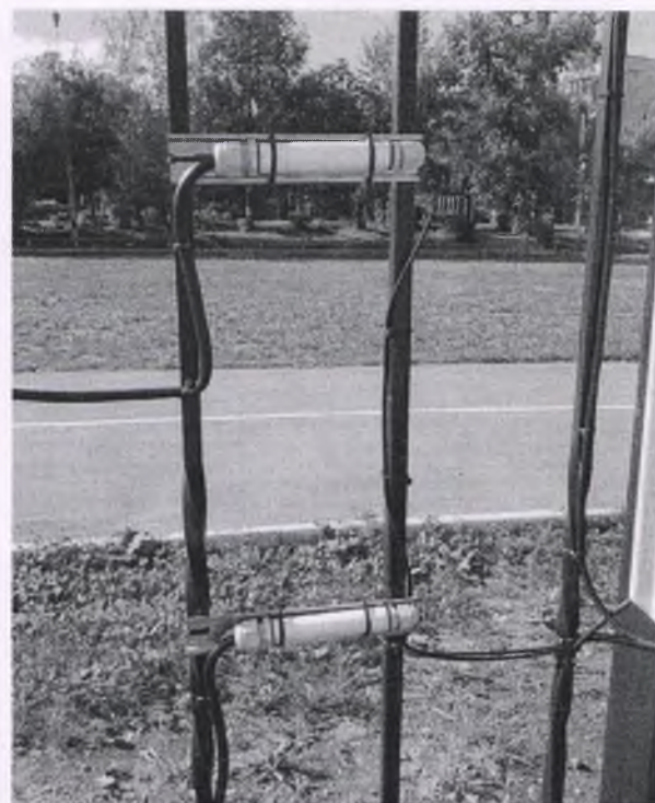
Рисунки 6, 7 – Внешний вид крепления ЧЭ и переходных муфт к полотну ограждения и к его опоре
