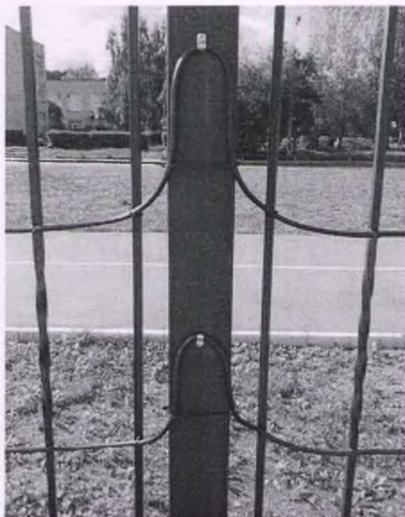
Рисунки 6, 7 – Внешний вид крепления ЧЭ и переходных муфт к полотну ограждения и к его опоре
