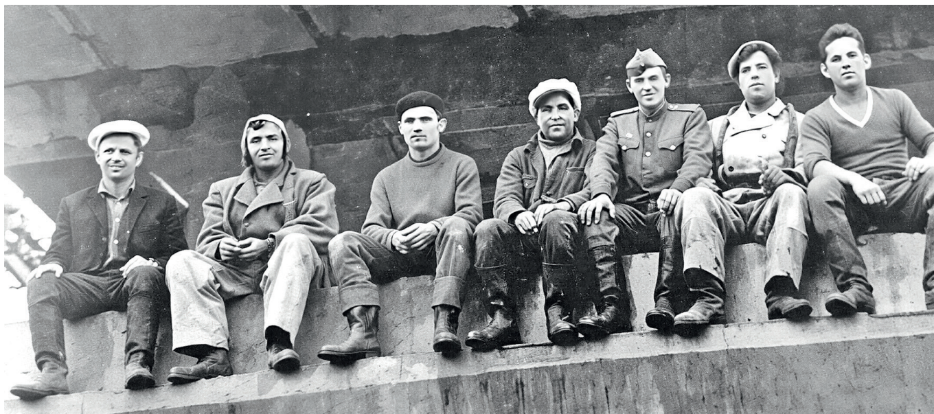
Монтажники из бригады Георгия Ярошенко
